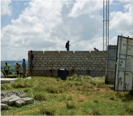
Das neue Gebäude in Timbaroa
