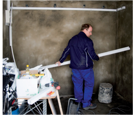
Kurt am Kabelkanal installieren
